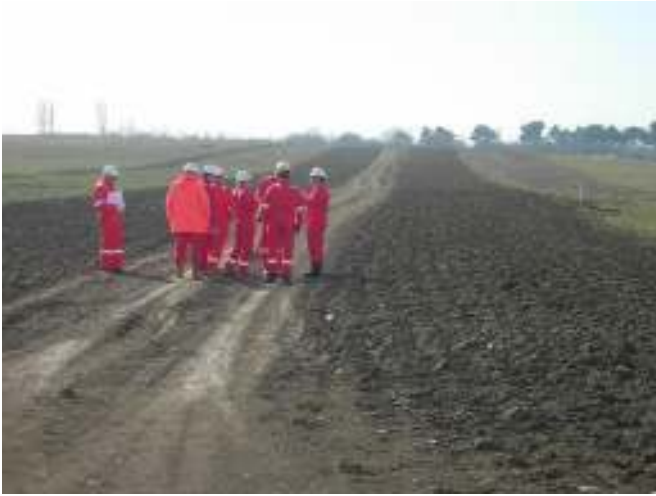
Şəkil 5. PK 411. Kəmər dəhlizi boyu yol kimi istifadə olunur. 6 Mart, 2006
