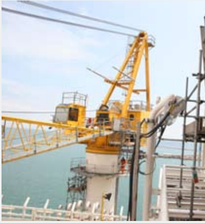
Şelflayihətikinti istehsalat sahəsində şəbəkə tipli dayaq blokunun inşası zamanı yükləmə əməliyyatları.
