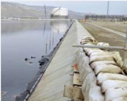
Səngəçal terminalında hasil edilmiş lay suları rezervuarı.
