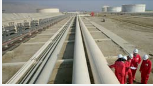
Senegal terminalında işçilər BTC boru kəmərinin yaxınlığında.
