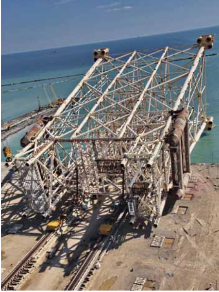
Qərbi Çıraq platformasının dayaq bloku daşıma barjasına yüklənir.
