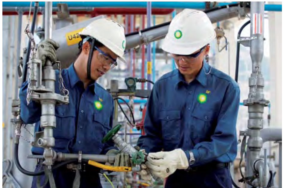
技术人员在珠海液化石油气厂工作，中国珠海
