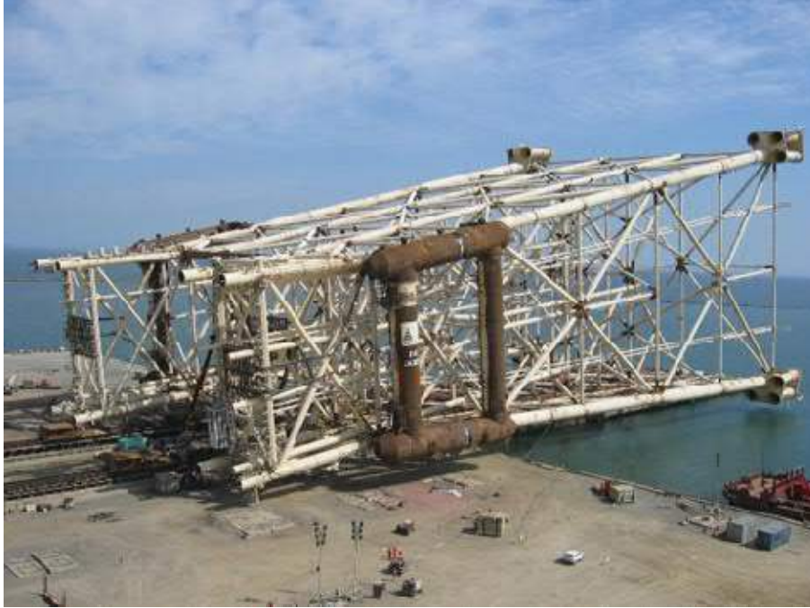
Şəkil 5.10 DərSG-YBQTT-nın dayaq bloku yükləmə zamanı
