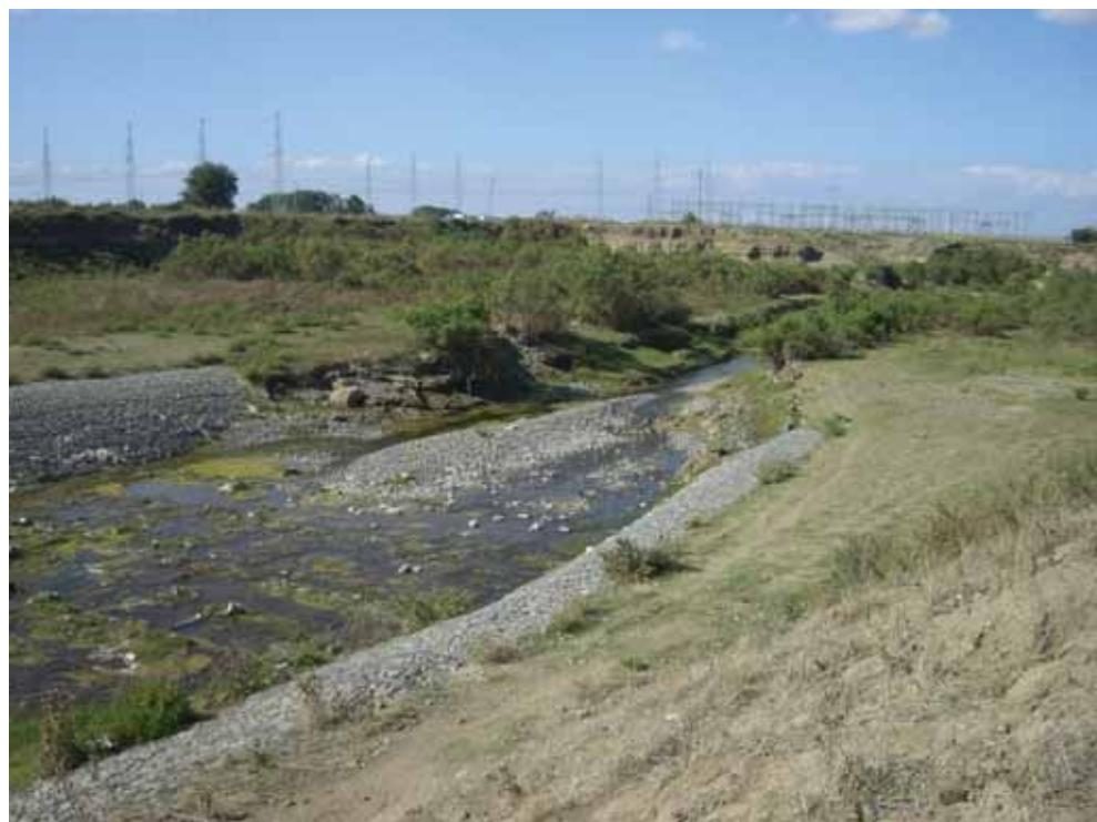
**Fotoşəkil 10-5: Gəncəçay BTC və CQBK Kəsişmə Nöqtəsində Mövcud Sahil Dəmir-Beton Bərkitmə İşləri**
