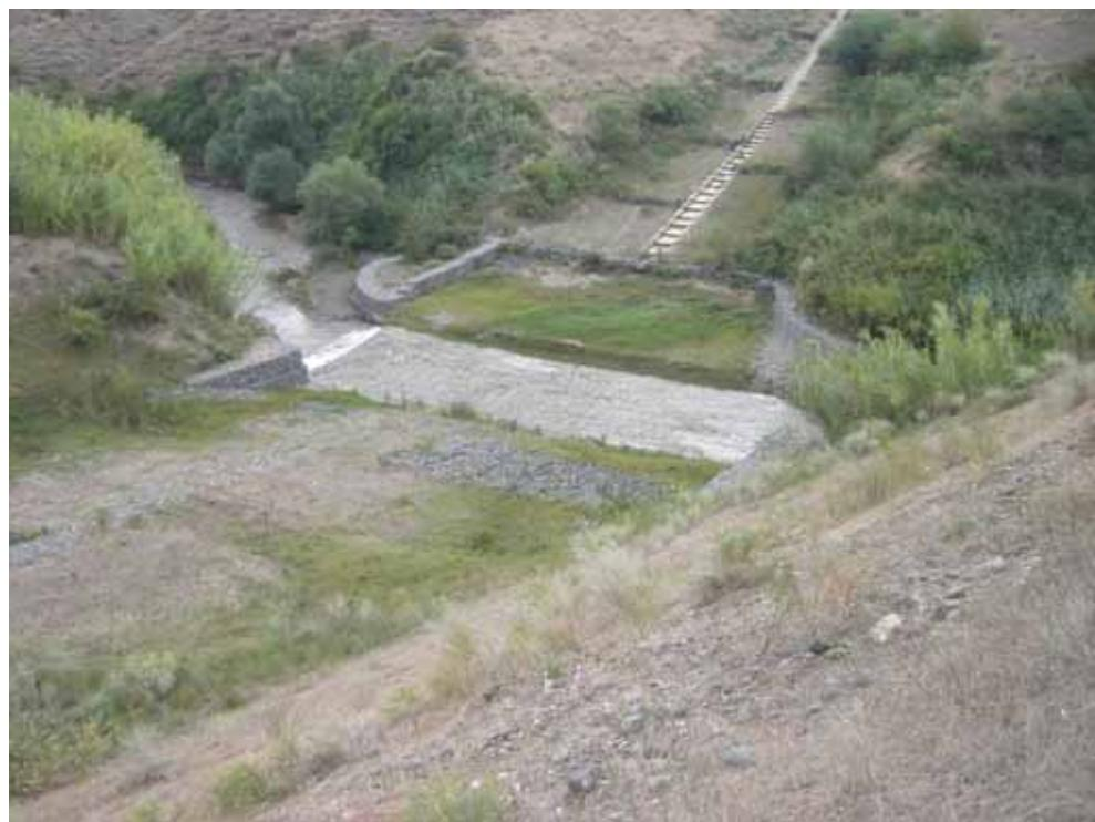
**Fotoşəkil 10-6: Həsənsu BTC və CQBK Kəsişmə Nöqtələrində Yeni Quraşdırılmış Sahil Dəmir-Beton Bərkitmə işləri**
