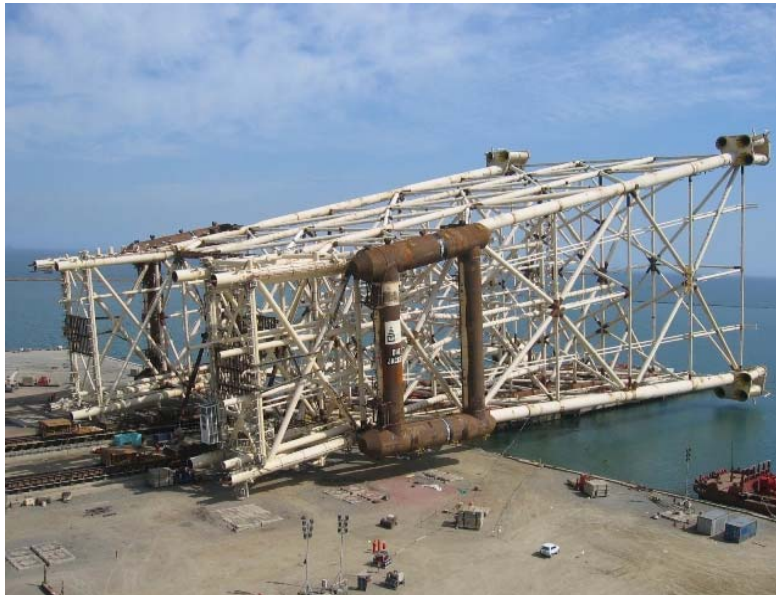
Şəkil 5.12 Dər SG-YBQTTP-nin dayaq bloku barja yüklənərkən
