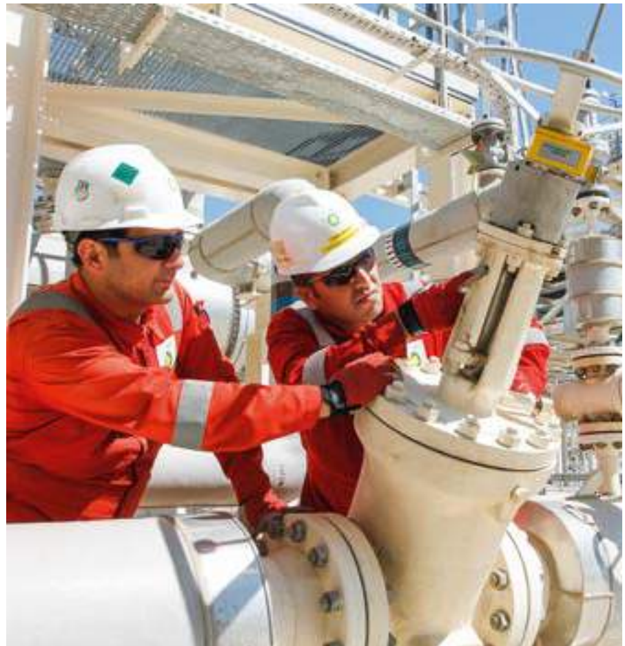
Mühəndislər quruda Şahdəniz 2 üzrə aparılan layihə fəaliyyətləri çərçivəsində açıq drenaj suları nasosunun istismara vermə sınağını aparırlar.
