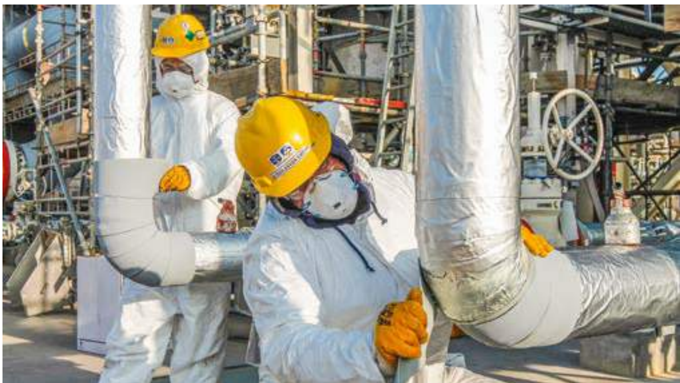
İşçilər Səngəçal terminalında boru hissələrini izolyasiya edirlər.
