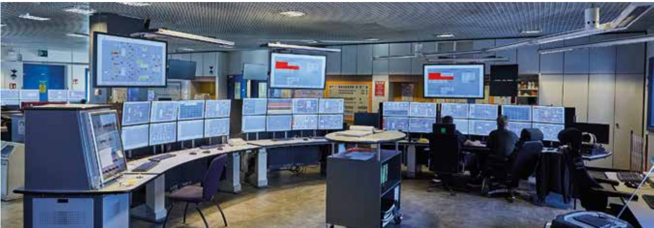
In dieser Messwarte werden die Komponenten der Anlage Olefin 4 gesteuert.
