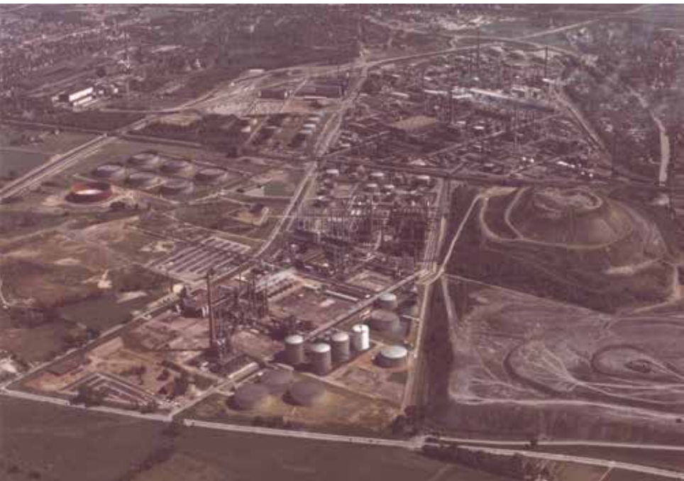
Das Werksgelände aus Richtung Norden, 1974. Im Vordergrund die Destillation 8, in der Bildmitte die Olefin-Anlage 3.
