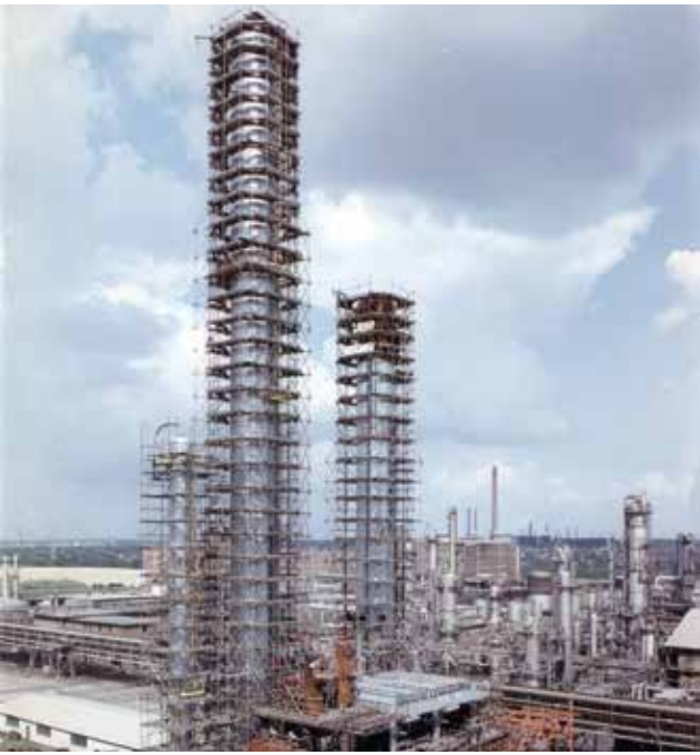
Bau der ortho-Xylol-Anlage, 1972.
