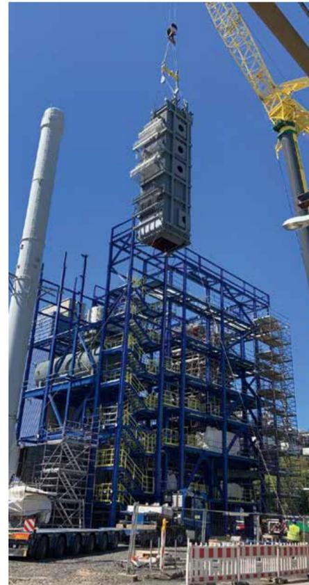
Ein spannender Moment auf dem Baufeld: Der Hochdruck-Dampfkessel wird mit Hilfe eines Krans in den Stahlbau eingehoben.
