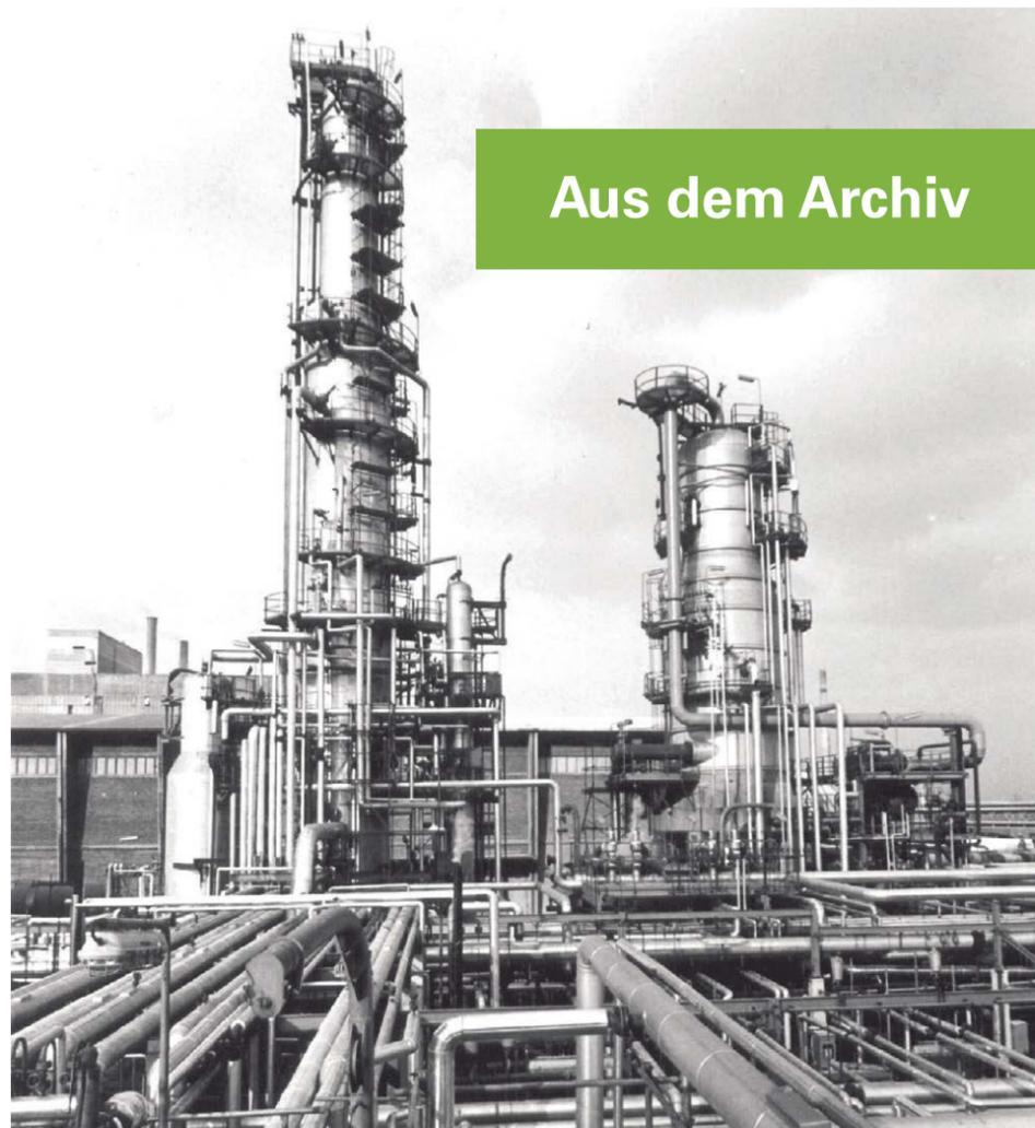
Als Ersatz für die Hydrierung wurde in Scholven 1963 der erste „Visbreaker“ – „viscosity breaking“ = Verminderung der Viskosität – in Betrieb genommen.
