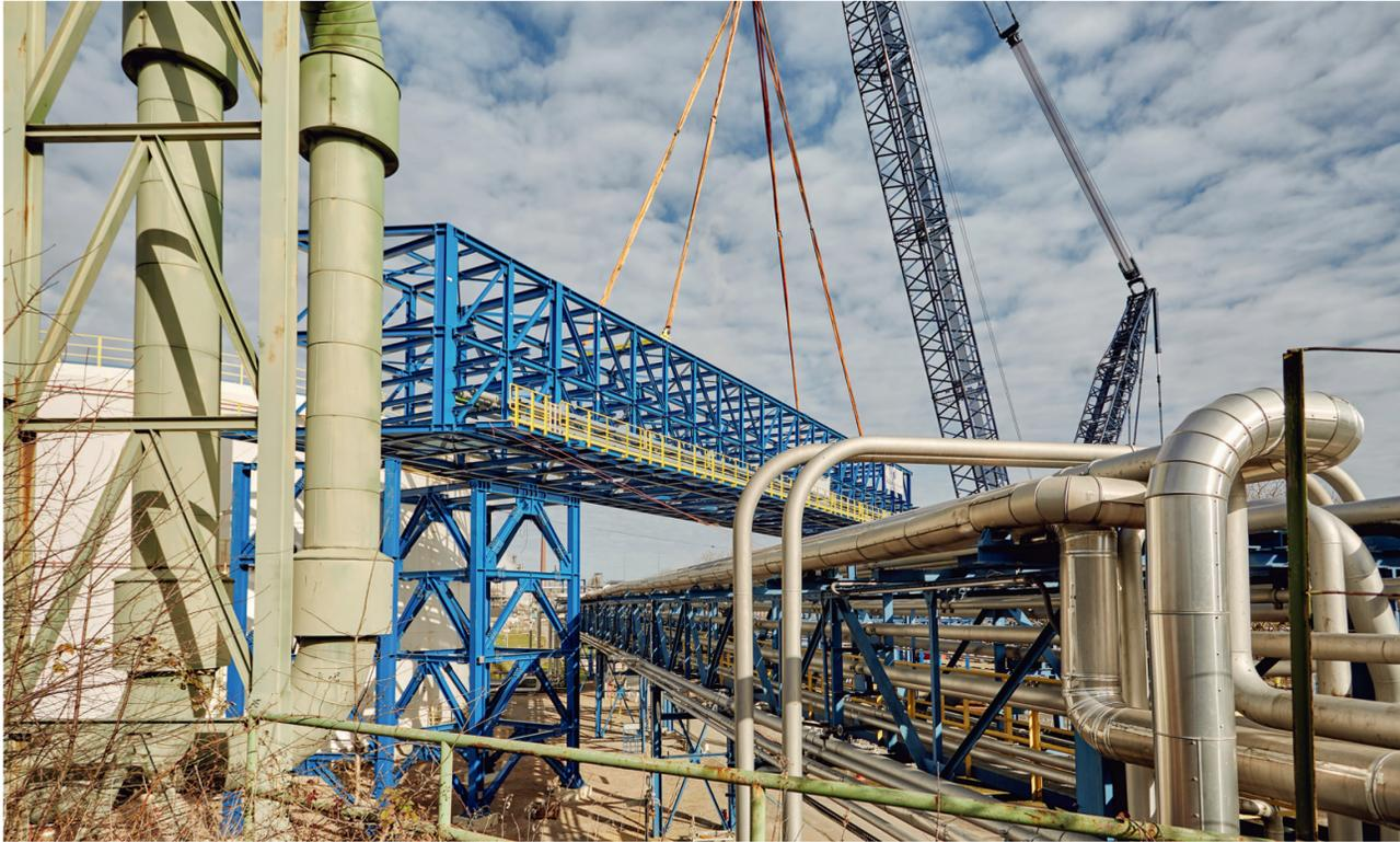
**Vom 19. bis zum 21. März wurde der erste von insgesamt drei wichtigen Schwerlasthüben im Steam & Power Projekt umgesetzt. Dafür wurden zunächst drei Stützen mit einem Gewicht von 64 Tonnen errichtet.**
