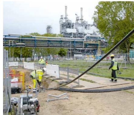
Kabelverbindungen zu haben. Im ersten Bauabschnitt müssen 36 parallele Einzeladern verlegt werden. Dazu kommen noch einige Datenleitungen für Fernbedienung und Datenübertragung. Mit den übrigen vier Bauabschnitten starten wir jetzt im Juni.
