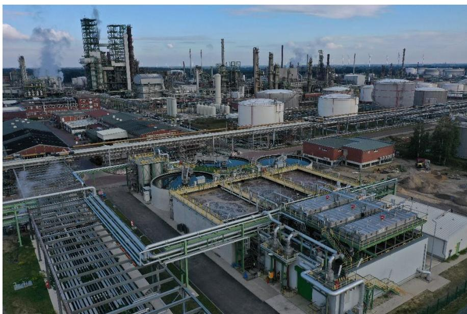
Die neue Kläranlage vor dem Hintergrund der Raffinerie-Skyline: oben Feinfilter und Nachklärbecken mit den davorliegenden Belebungsbecken der Biologie, unten rechts im Bild die
