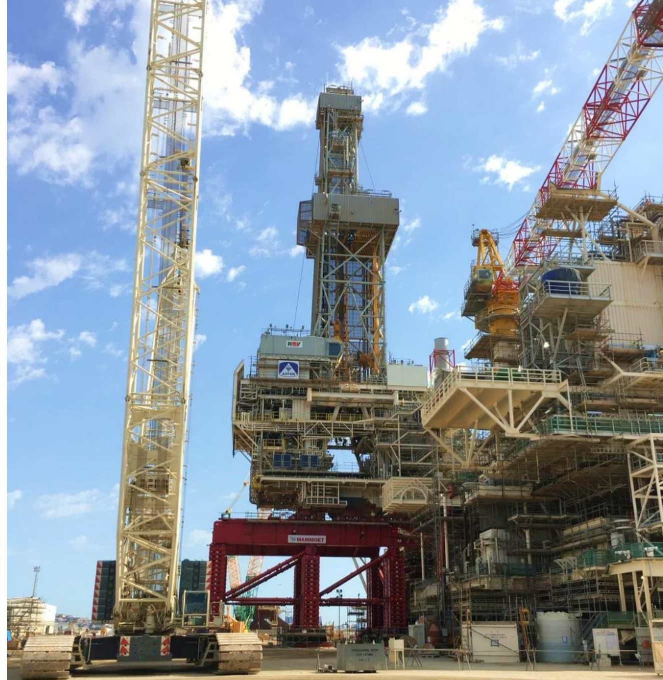
Bibiheybətdə qazma qurğularının “qaldırma və sürüşdürmə” əməliyyatı
