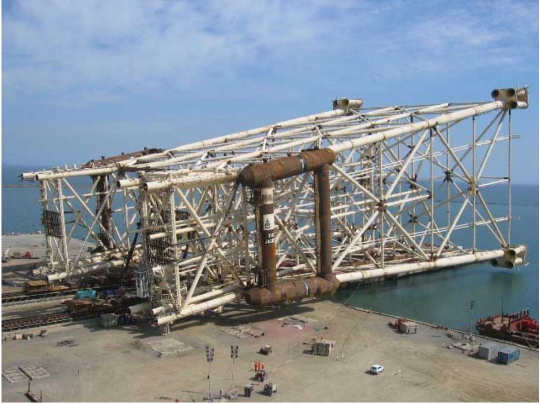
Şəkil 5.7: DərSG-YBQTT platformasının dayaq bloku yükləmə zamanı
