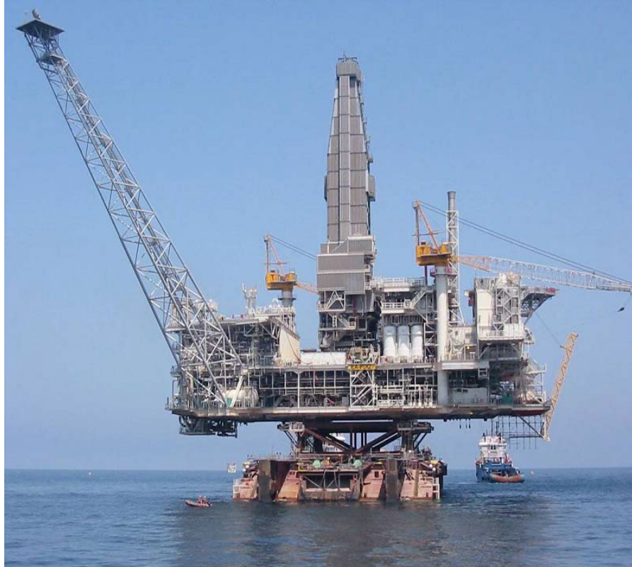
Şəkil 5.8: STB-1 barjasının göyertəsində ŞA platformasının üst tikilisi
