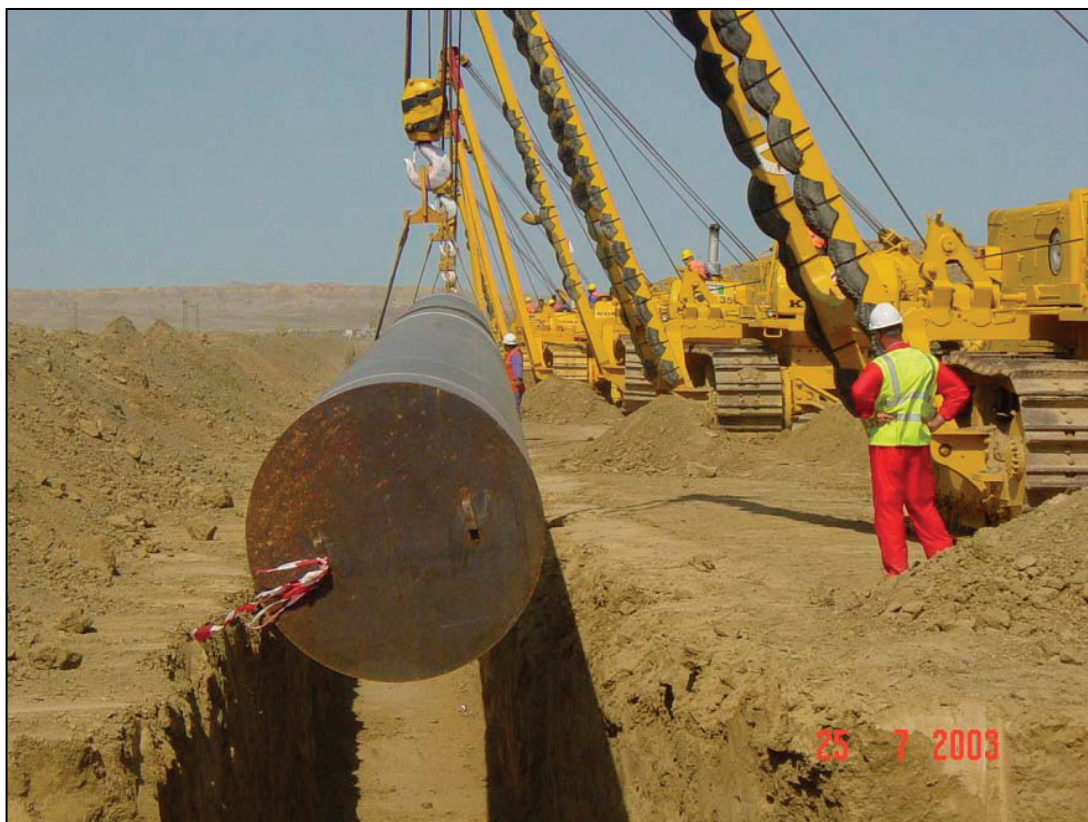
სურათი 5-6: მილსადენის თხრილში ჩადება
