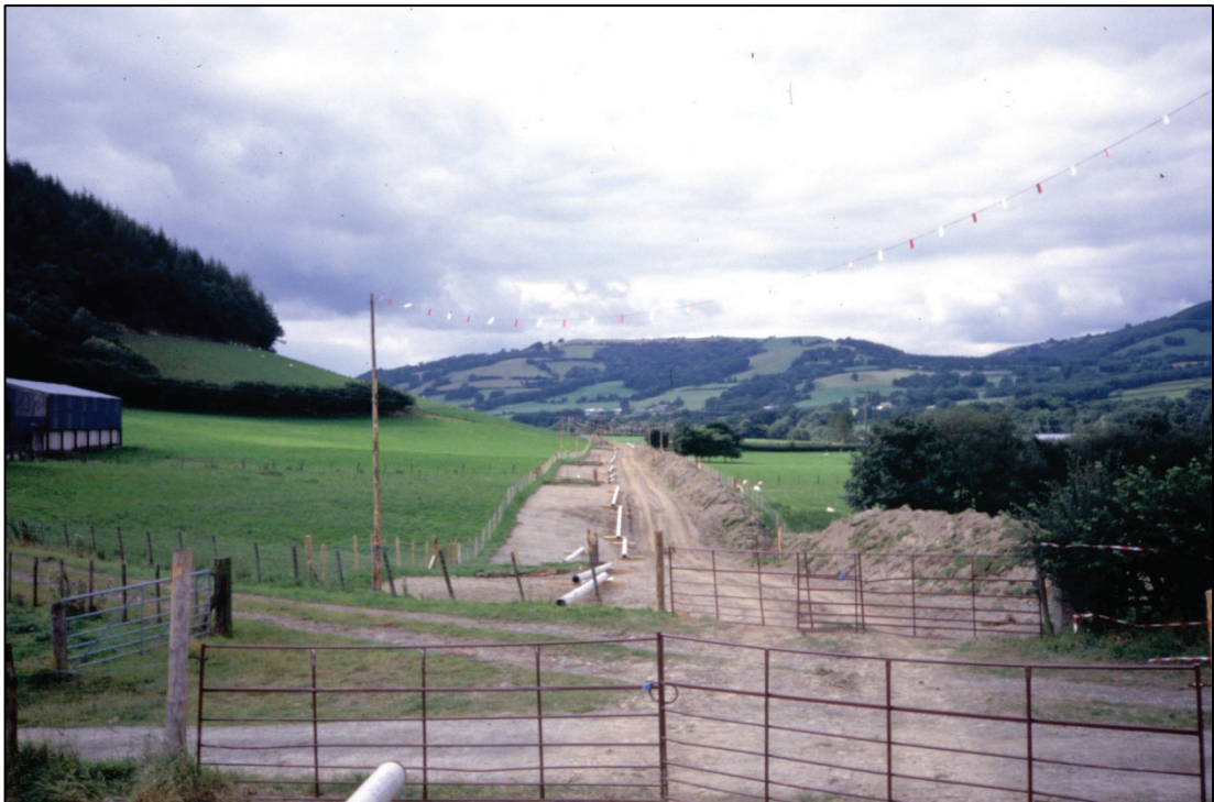
სურათი 5-3: მილსადენის მწკრივად დაწყობის ტიპური ვარიანტი
