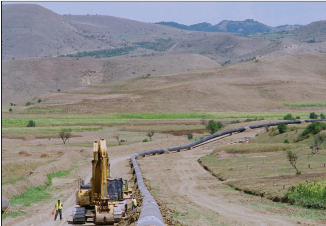
სურათი 5-4: შედუღებული მილების მონაკვეთი
