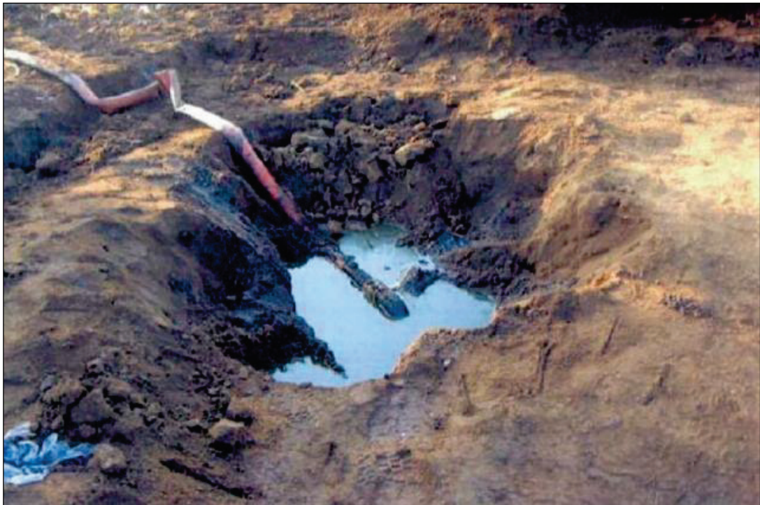
ფოტოსურათი 7-1: უკანონო ნახვრეტით გამოწვეული ნიადაგის დაბინძურების მაგალითი
