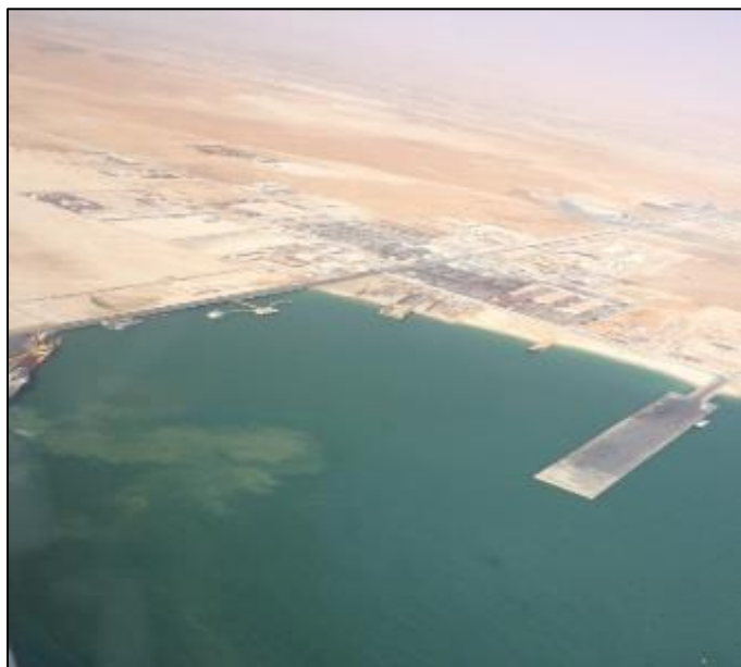
Photo 4-31 Vue du Port de Nouakchott
