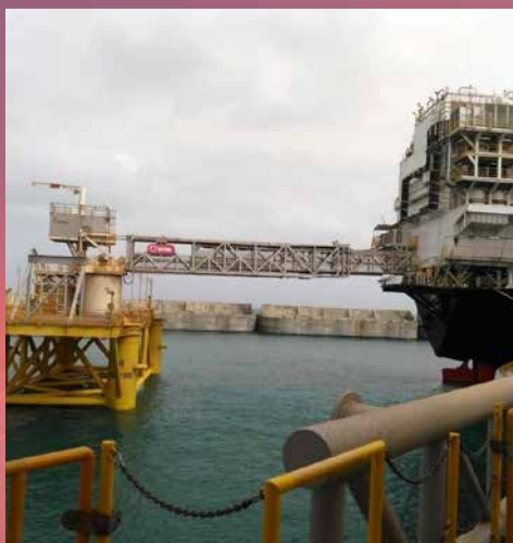
Passerelle du FLNG au Hub
