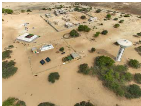
Vue aérienne du projet d'eau
