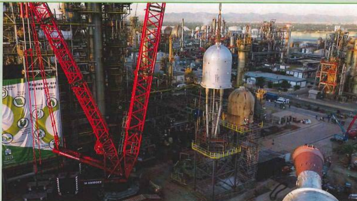
Maniobra de izado de la cabeza del regenerador del FCC durante la GTAR
