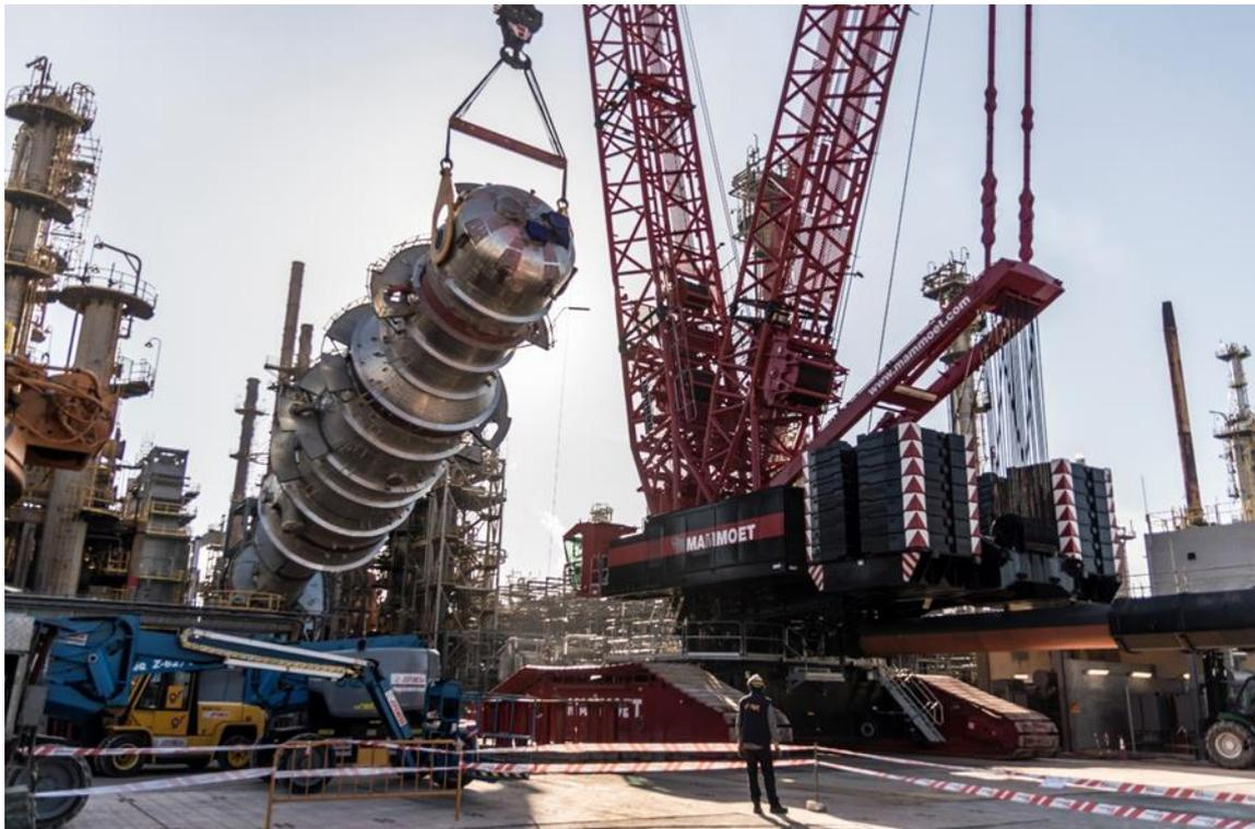
*Izado de la nueva torre de destilación a vacío*
