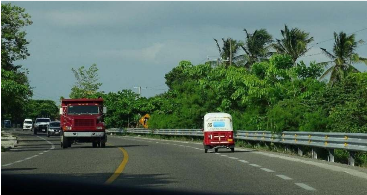
Fotografía 2-26. Carretera Pavimentada El Bellote en Puerto Ceiba
