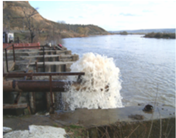
სურათი 40, 41 ჰიდროტესტირების წყლის ჩაშვება გაფრქვევის გზით
