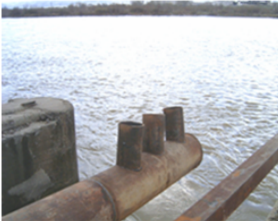
სურათი 40, 41 ჰიდროტესტირების წყლის ჩაშვება გაფრქვევის გზით
