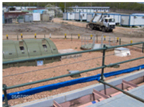
სურათი 35, 36 თეთრიწყაროს ბანაკის RBC ტიპის დანადგარი
