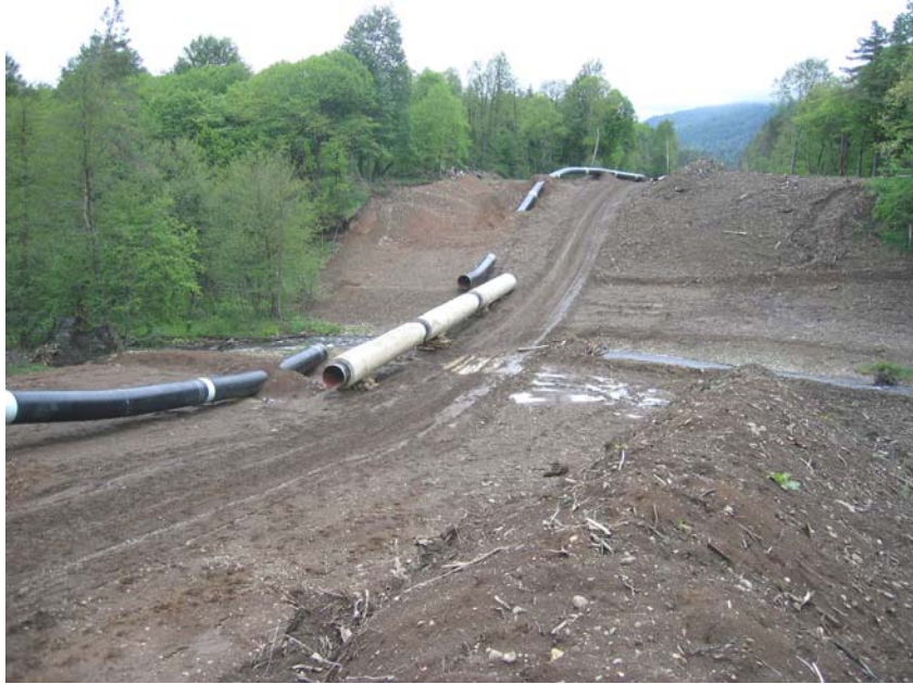
სურათი 14. KP-183- მდ. კუმისკას კვეთა. ნავთობსადენი ჩადებულია და მიმდინარეობს გაზსადენის მშენებლობა.
