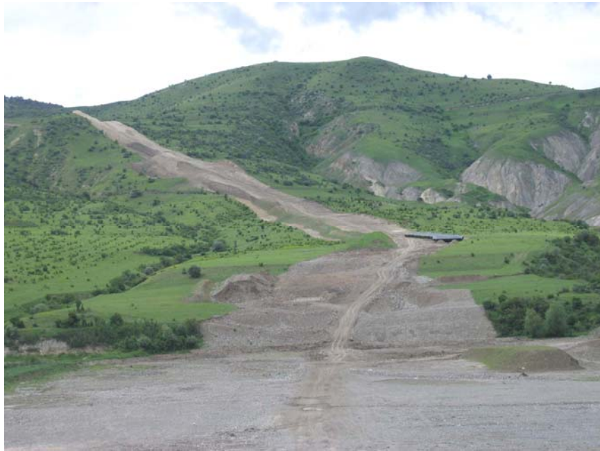
სურათი 15 KP-243 – მდინარე ფოცხოვის კვეთა 2. ციცაბო ფერდობი, რომელზეც არ არის ჩატარებული ანტიეროზიული ღონისძიებები
