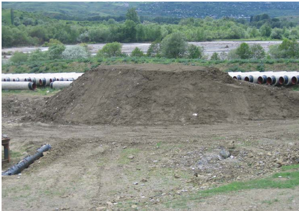
სურათი 2. KP 238 – მდინარე ფოცხოვის კვეთა 1, ნიადაგის ქვედა ფენის ყრილები. უკანა ფონზე ჩანს ბალახით დაფარული ნიადაგის ზედა ფენა
