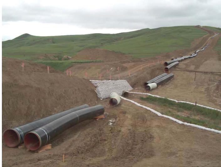
სურათი 8. დროებითი ანტიეროზიული ზომები ქვიშის ტომრების გამოყენებით
