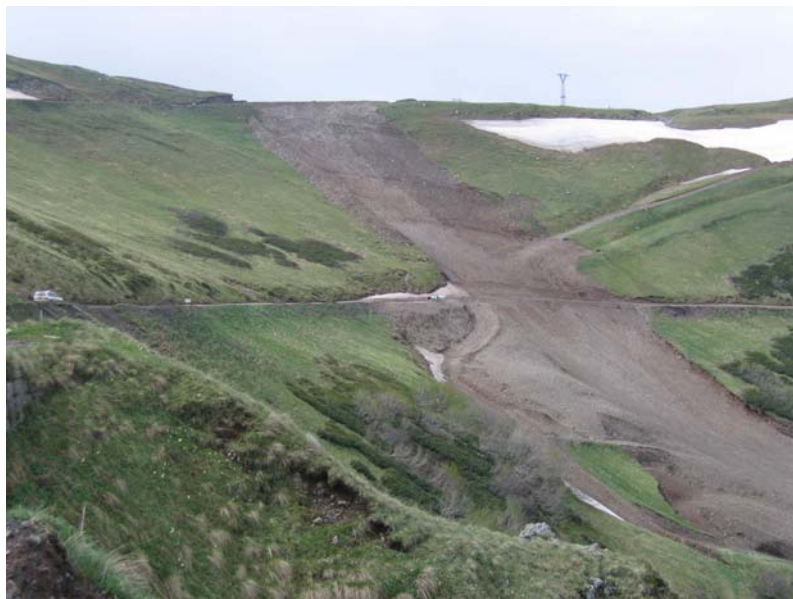
სურათი 7. KP 176 – ცხრაწყაროს უღელტეხილი. დროებითი ანტიეროზიული ზომები განხორციელებულია ბერმების გამოყენებით
