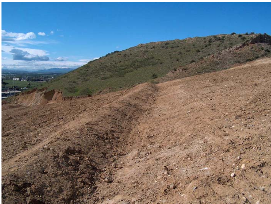
სურათი 6. KP 28-29 - მდ. მტკვრის კვეთა-1 (აღმოსავლეთ სანაპირო) ციცაბო ფერდობებზე მიმაგრებულია ანტიეროზიული ბერმები
